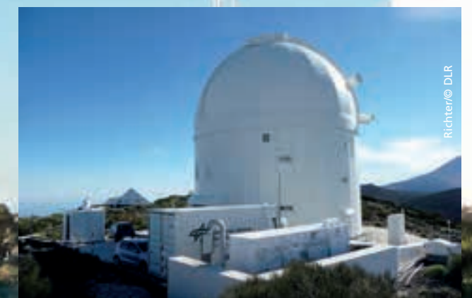
Passt auf einen Lkw: Die mobile Bodenstation T-AOGS besteht aus zwei Containern. Der kleinere (hinten) mit dem Teleskop kann in dem größeren mit dem Kontrollzentrum verstaut werden. Hinter dem großen Container ist die optische Bodenstation der ESA zu sehen.
